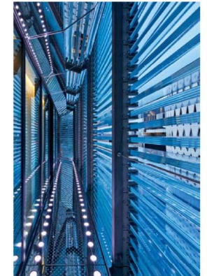
避難バルコニーとガラスルーバーの間の床面および天井を鏡面仕上げとし、ドット型LED照明をアッパーに設置。光が乱反射することで、ファサードに幻想的なシーンをつくり出す
