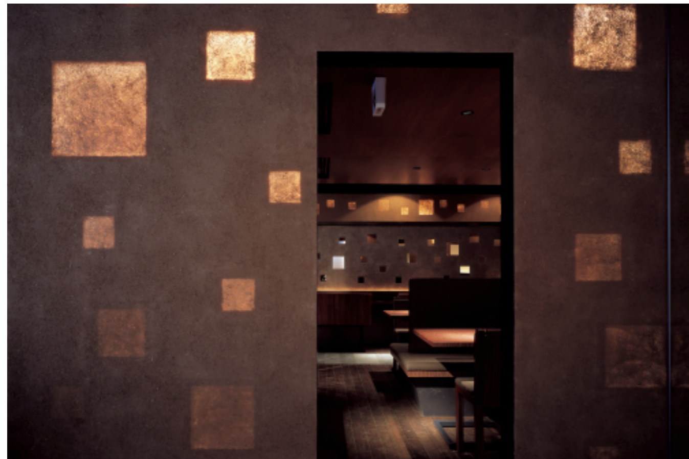
個室席から中央の客席側を見る。光源にテーブルライトを用いた内照部はアクリル象嵌の上に厚さ0.5mmの特殊左官土壁
